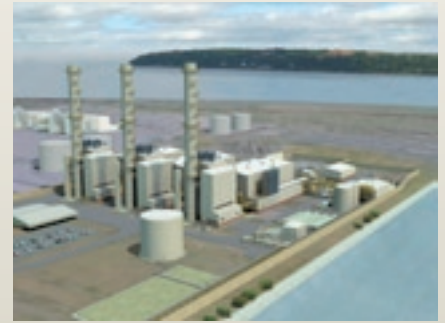
GRAIN UK 3 x KA26-1 SS – 1275 MW Hot water for LNG terminal
