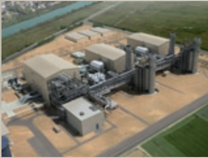
TKS CSA RIO DE JANEIRO Brazil 1 x KA11N2-2 LBtu – 497 MW
