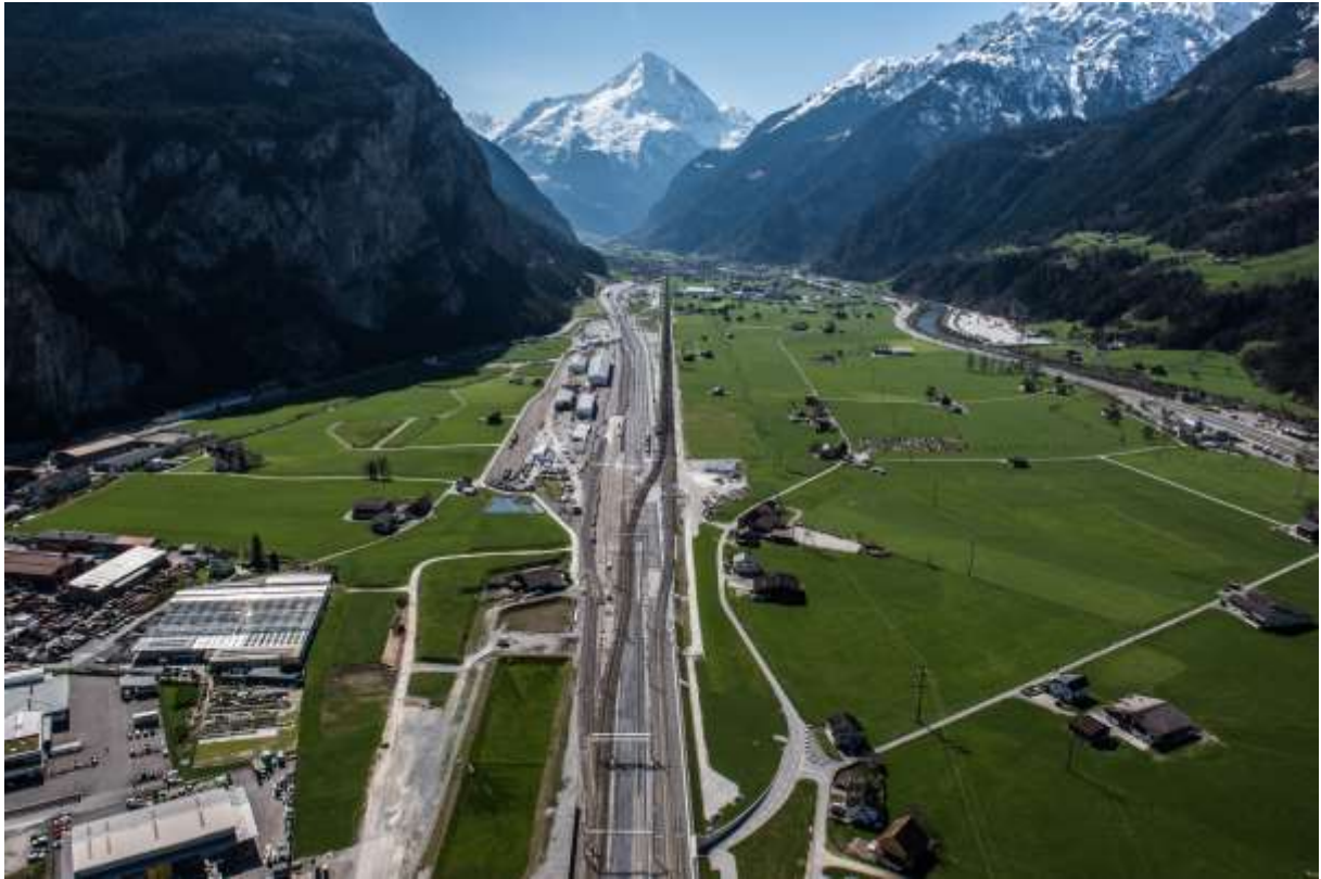
Copyright Alp Transit Gotthard AG, Gotthard-Basistunnel Luftaufnahme Nord
